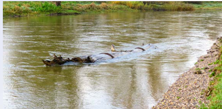
Die Stämme werden mit Ketten verankert, damit sie nicht abtreiben und keine Schäden verursachen.
